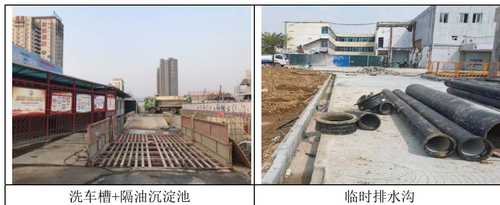
图 7-2 施工期水污染防治措施
