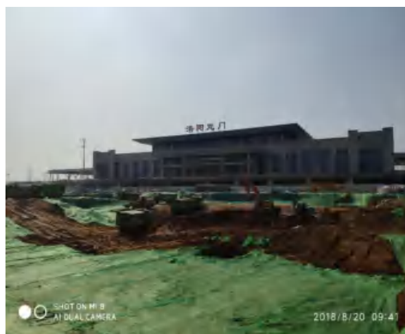
临时措施-裸露地面土工布苫盖
