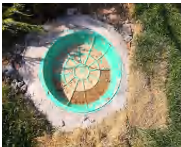
工程措施-雨水井
