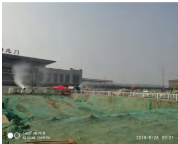
临时措施-密目网苫盖
