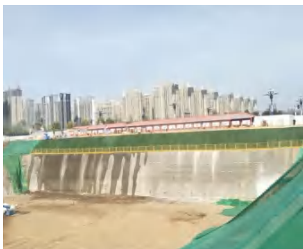
临时措施-密目网苫盖
