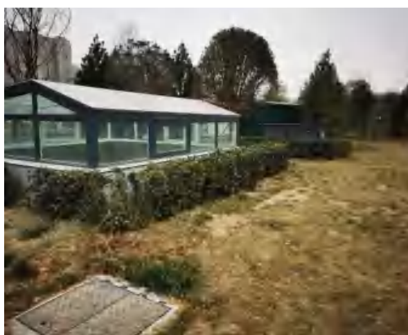
工程措施-回填轻质土
