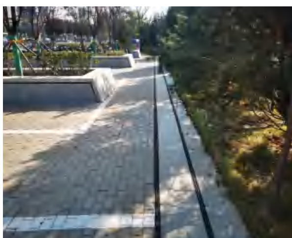
工程措施-盖板排水沟
