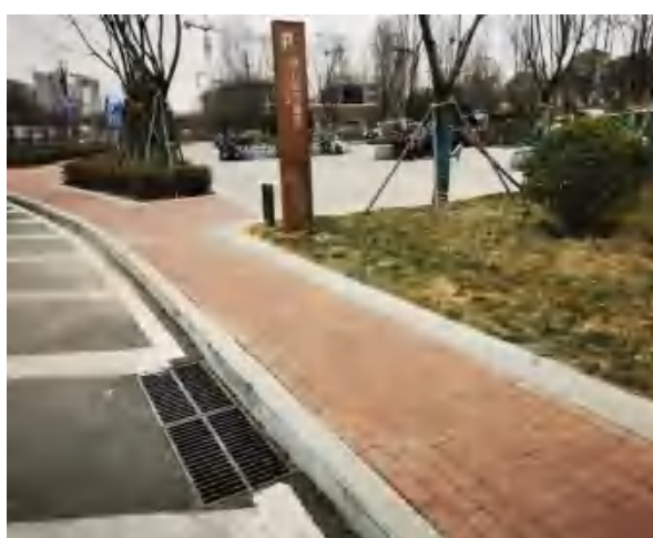
工程措施-波纹管排水沟
